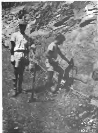
DETERMINATION AU MARTEAU DE GEOLOGUE D'UNE SURFACE DE ROCHER SAIN
